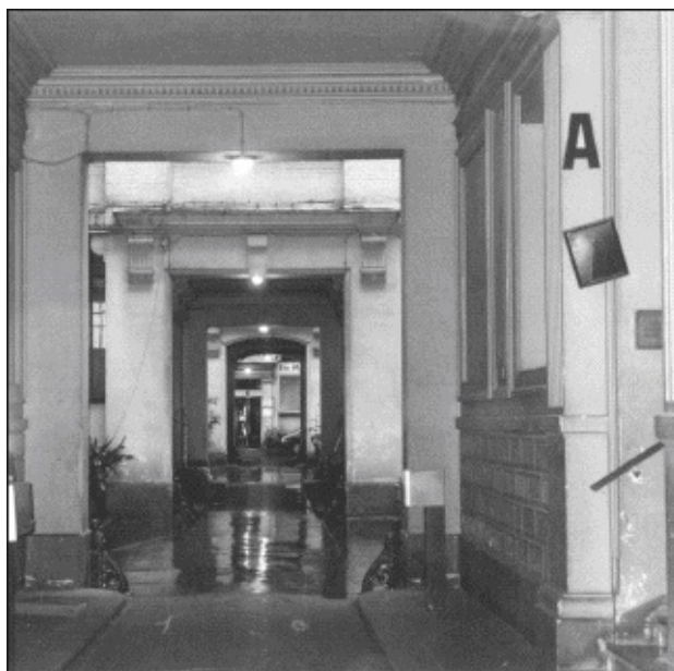
Interior del portal del 4 de la rue Martel.
