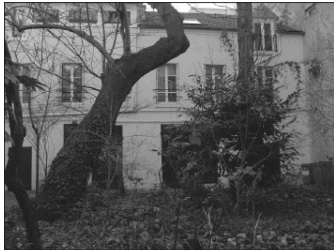
Patio interior de la casa de la place du Général Beuret.
